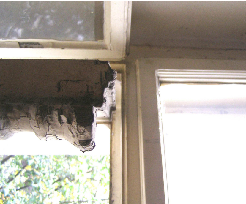
DETAIL PROFILACE RÁMU VNĚJŠÍHO OKNA
