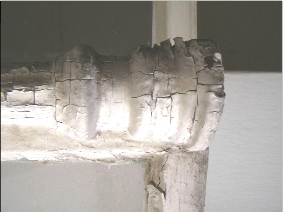
DETAIL RÁMU VNĚJŠÍHO OKNA
