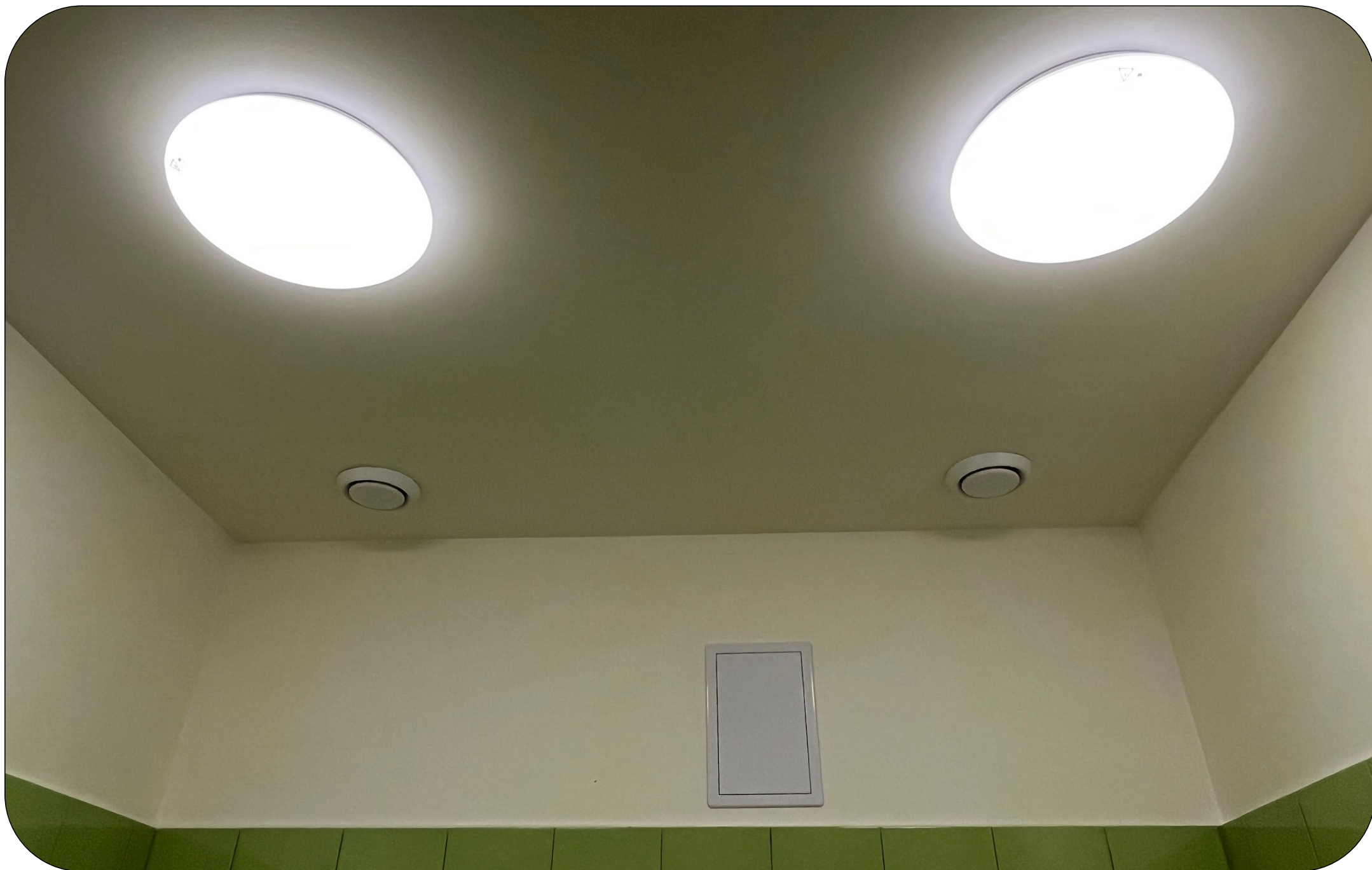
PŘÍKLAD ŘEŠENÍ SVĚTEL A DISTRIBUČNÍCH ELEMENTŮ VZT NA REKONSTRUOVANÝCH WC
