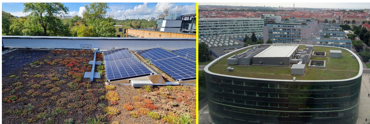
Obrázek 17 Biosolární střecha na škole COPaG Českobrodská (foto Jiří Tencar); zelená střecha budovy NTK, Praha (foto Jan Růžička)
