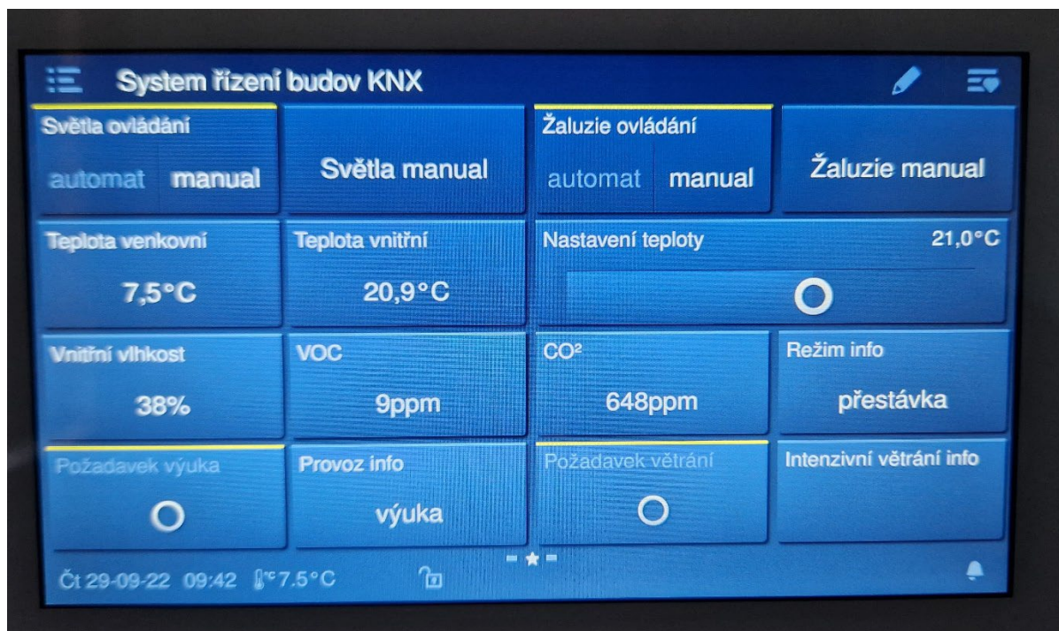
Obrázek 13 Dotykový tablet v učebnách pro ovládání osvětlení, žaluzií a teploty a sledování ostatních environmentálních parametrů ve škole COPaG Českobrodská (foto Jiří Tencar)
