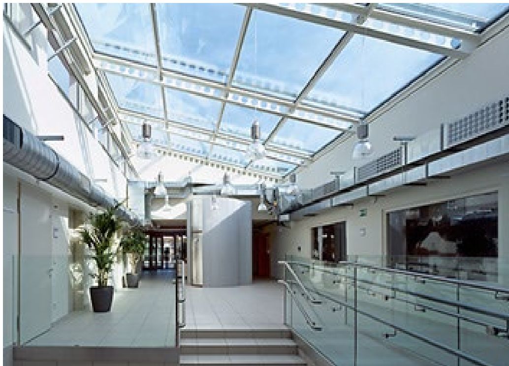
Obrázek 10 Technické zařízení jako součást designu interiéru budovy, hlavní zdroj energie jako centrální objekt ve vstupní hale, MŠ Schukowitzgasse, Vídeň (foto www.reinberg.net )
