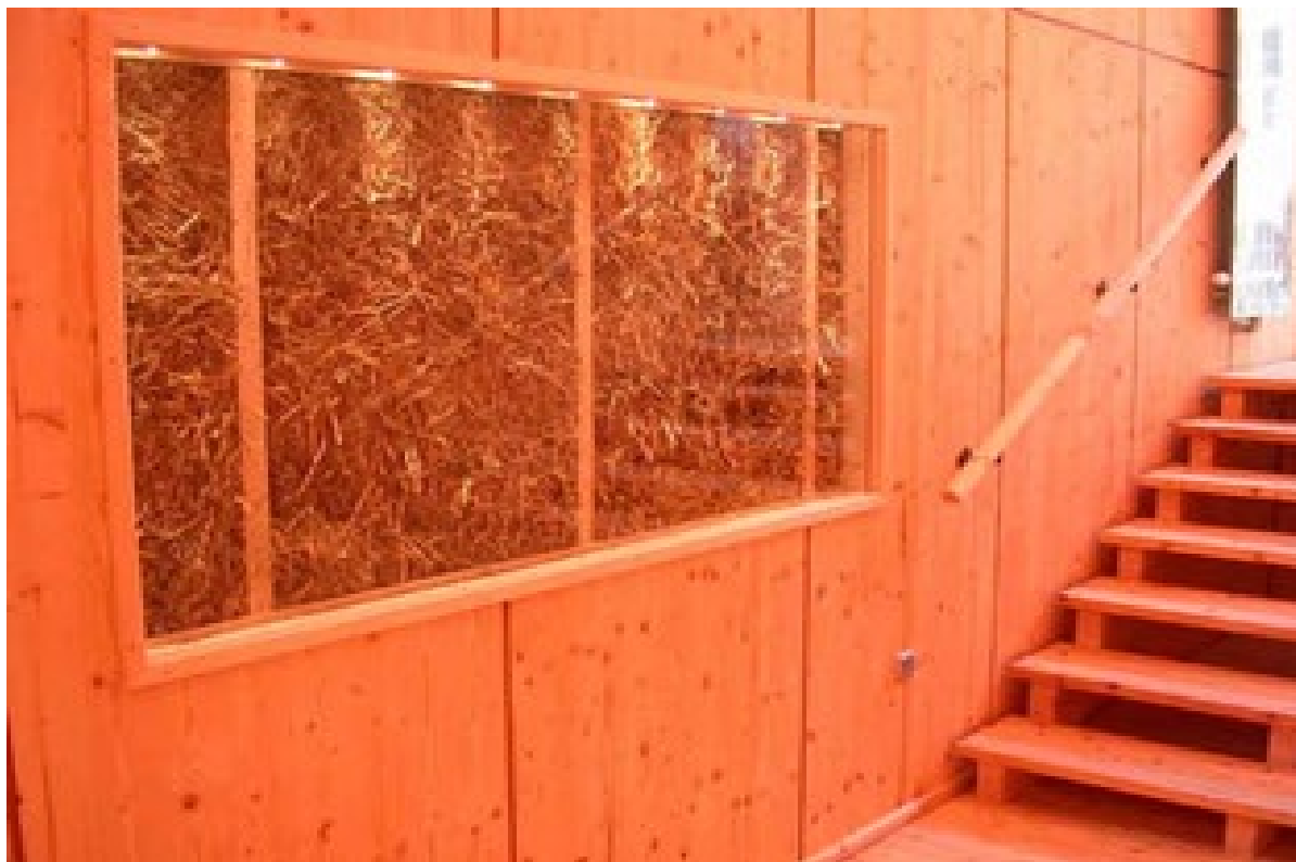
Obrázek 12 Přiznaná konstrukční část ve škole Allentsteig, Rakousko (foto Jan Růžička)
